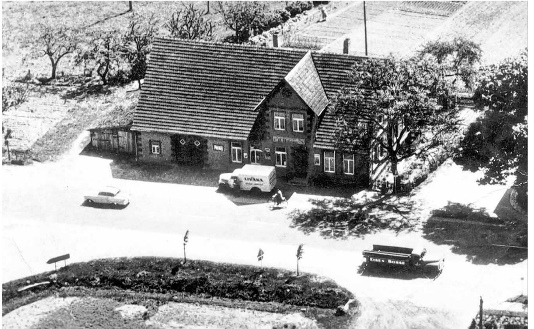
Der Verkehr an der Kreuzung in Leckerstraße nahm um 1960 stetig zu.
